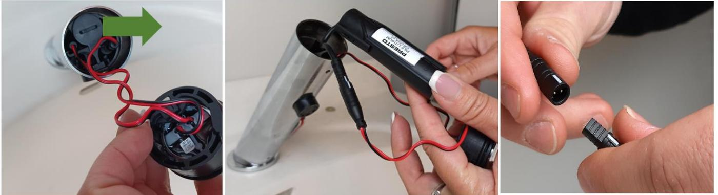
Débrancher le boîtier pile. Enlever les piles du boîtier et les déposer dans un endroit adapté au recyclage. Mettre en place les nouvelles piles. Reconnecter le boîtier pile en prenant soin de positionner correctement les détrompeurs.
