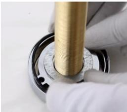
Placer la commande dans le mur sans oublier le joint entre le mur et le socle
