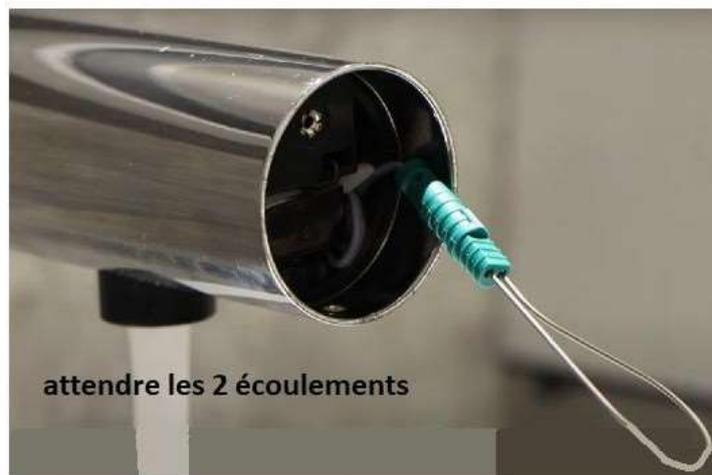
Retirer alors le shunt et **ne pas placer ses mains** ou autres objets entre la cellule et le fond de la vasque **pendant 30 secondes**. La cellule réalise ainsi son autoapprentissage.
