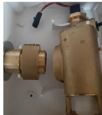
Écarter le robinet du robinet d'arrêt et sortir le robinet du boîtier d'encastrement.
